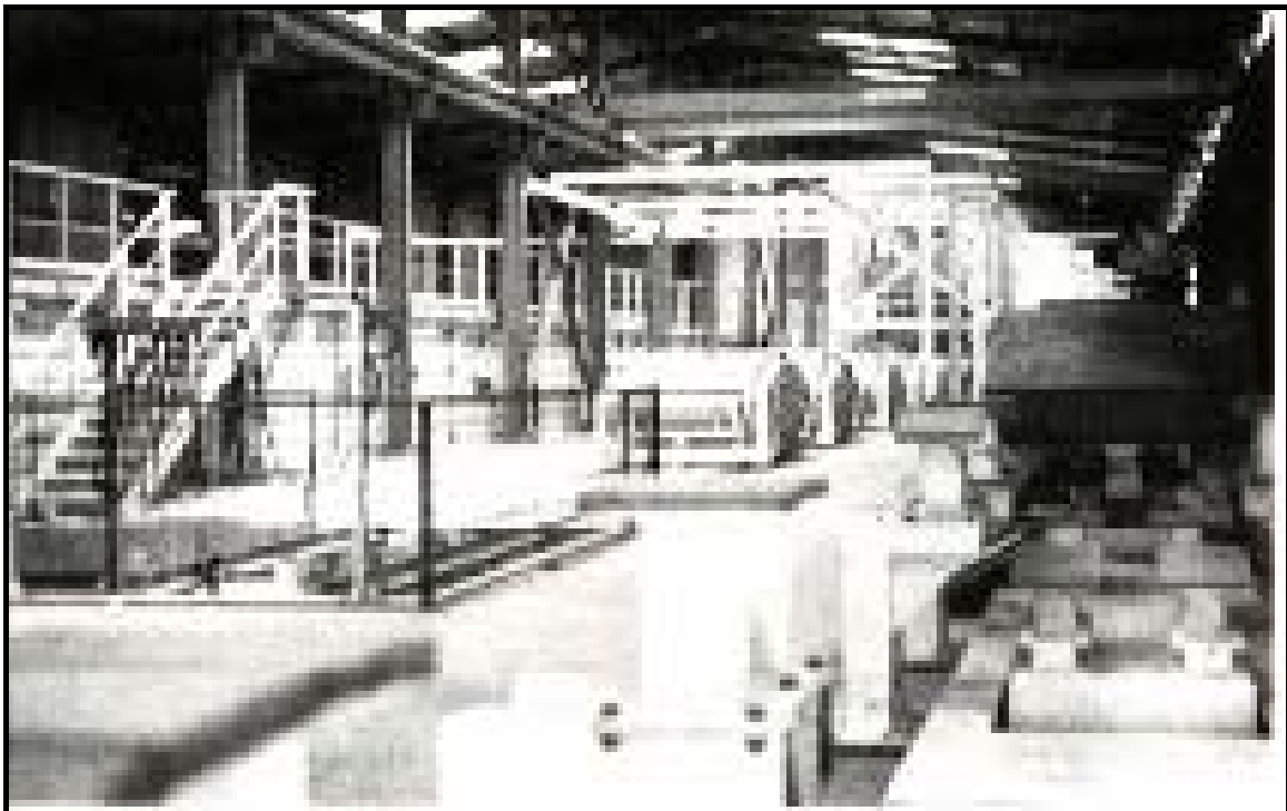
Σχήμα 32γ. Εργοστάσιο προκατασκευής δακτυλίων επενδύσεως.
