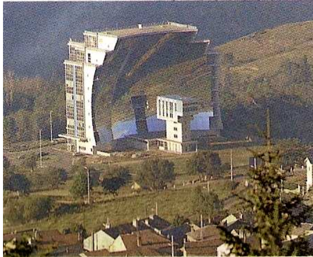
Εικόνα 3. Τεράστιο κάτοπτρο που αποτελείται από 3.500 μικρούς καθρέφτες, στο Μον Λουί των Γαλλικών Πυρηναίων, συγκεντρώνει το ηλιακό φως και το στέλνει σε μια περιορισμένη περιοχή, αναπτύσσοντας θερμοκρασία 3.000^{\circ}\text{C}
