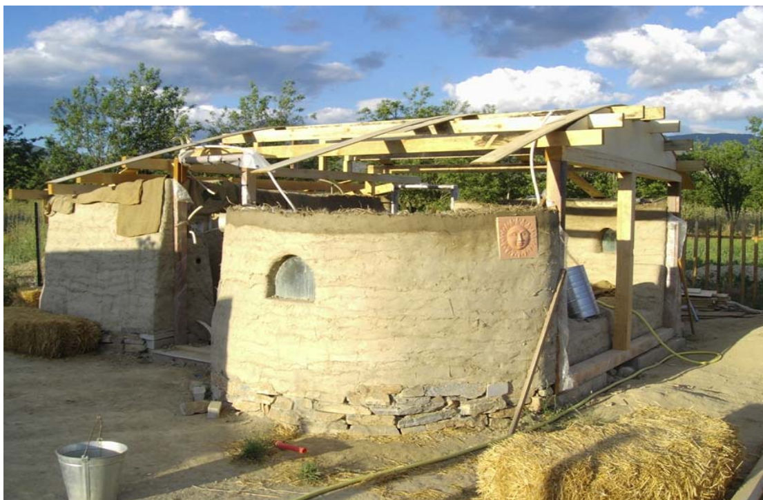
Εικόνα 11 : Κατασκευή παραδοσιακής κατοικίας
