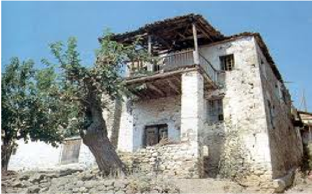
Εικόνα 12 : Ερειπωμένη παραδοσιακή κατοικία με ανακυκλώσιμα υλικά
