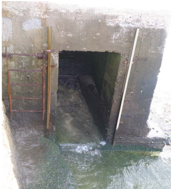
Εικόνα 17 :Η τσιμεντένια ορθογωνικής διατομής κατάληξη του προς μελέτη αγωγού
