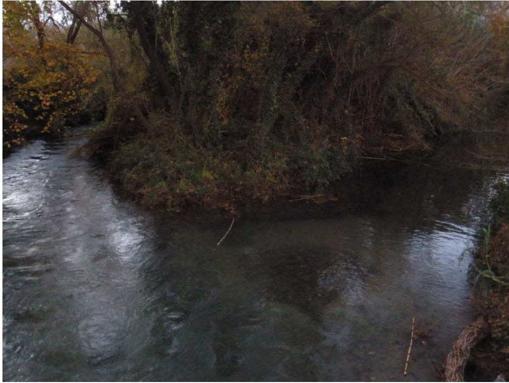
Εικόνα 14. Στάθμη νερού Σφακοπέρασμα γέφυρα (18/12/09)
