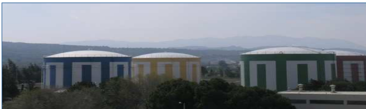
Εικόνα 2.4: Δεξαμενές αποθήκευσης μαζούτ
