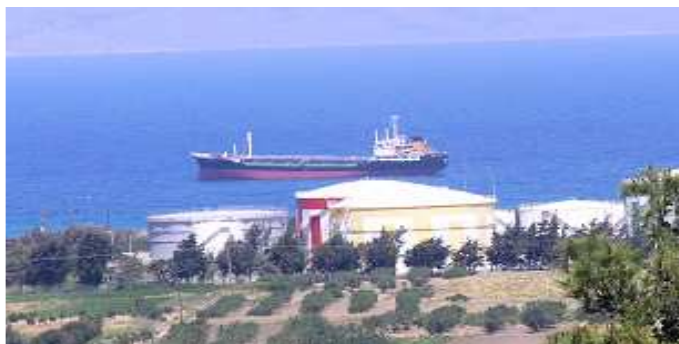
Εικόνα 2.3: Δεξαμενόπλοιο τροφοδότησης με καύσιμα
