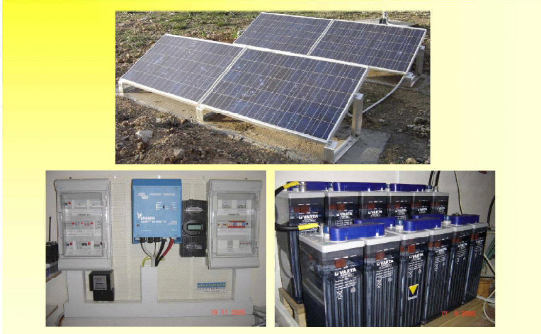
Σχήμα 25 Παράδειγμα Αυτόνομου Φ/Β συστήματος
