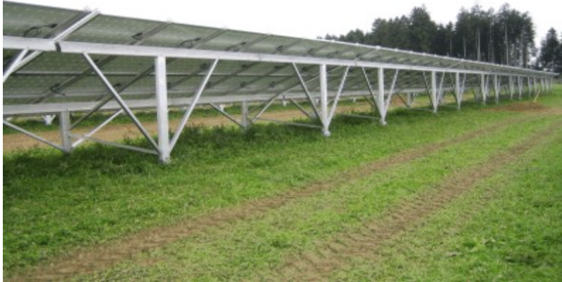
Σχήμα 38 Παράδειγμα στήριξης του συλλέκτη με σταθερή γωνία κλίσης.
