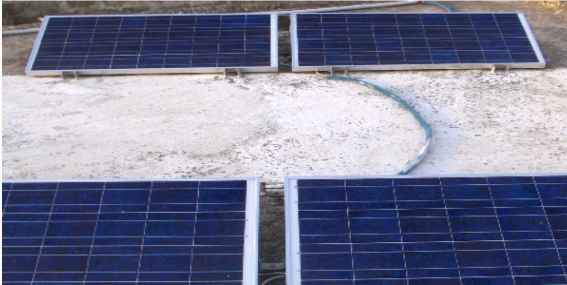
Σχήμα 44 Βλέπουμε δυο σειρές Φ/Β πλαίσιων αποτελούμενες από δυο Φ/Β πλαίσια συνδεδεμένα σε σειρά ώστε να έχουμε τάση ίση με 24V στο σύστημα μας Η μελέτη & εγκατάσταση του συστήματος έγινε από την ΔΥΝΑΜΙΣ
