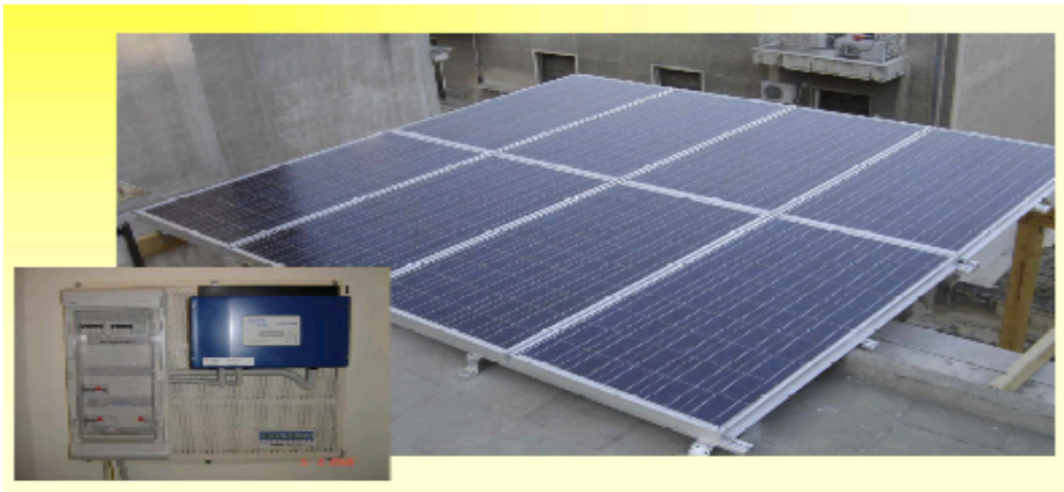
Σχήμα 28 Παράδειγμα Διασυνδεδεμένου Φ/Β συστήματος
