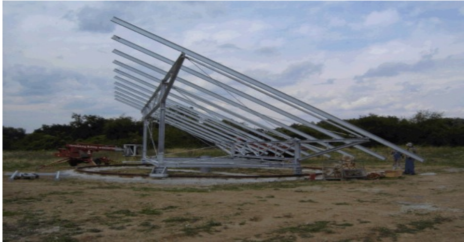
Σχήμα 39 Σύστημα παρακολούθησης ηλιακής ακτινοβολίας(ηλιοτρόπιο, san trucking system)
