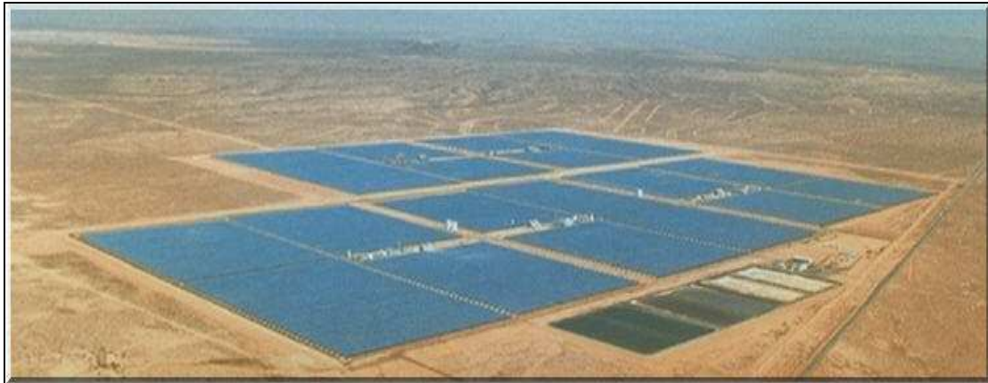
Σχήμα 3.10 Εναέρια φωτογραφία των πέντε επιμηκών παραβολικών εγκαταστάσεων των 30 MW στο Kramer Junction στην έρημο Mojave της Καλιφόρνιας.
