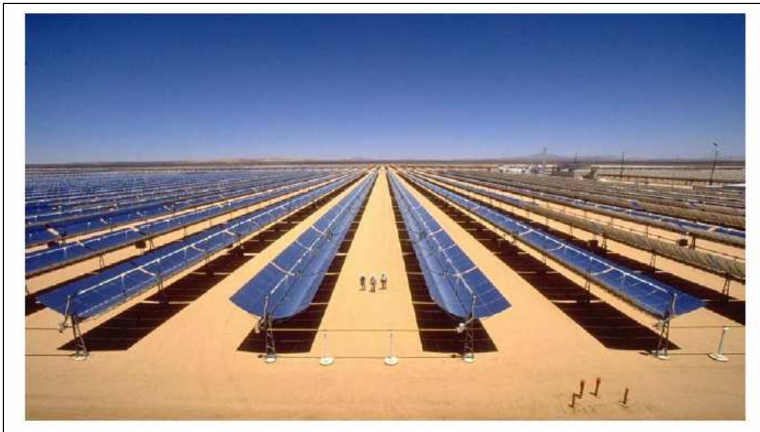
Σχήμα 3.11 Μία εικόνα από το ηλιακό πεδίο παραβολικών ηλιακών συλλεκτών των 30 MW SEGS III, στο Kramer Junction στην Καλιφόρνια. Το σχήμα δείχνει το μεγάλο πεδίο με σειρές από επιμήκεις παραβολικούς συλλέκτες [9].
