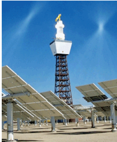
Σχήμα 3.22 Το σύστημα Solar Two σε λειτουργία από το 1996, στην Καλιφόρνια, για αποθήκευση και παράδοση ηλιακής ισχύς στο δίκτυο 24 ώρες ανά ημέρα.
