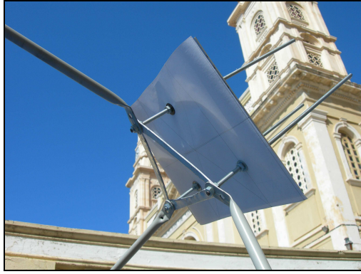
Σχήμα 5.15 Τοποθέτηση πλακέτας αλουμινίου στην απόσταση +4cm.
