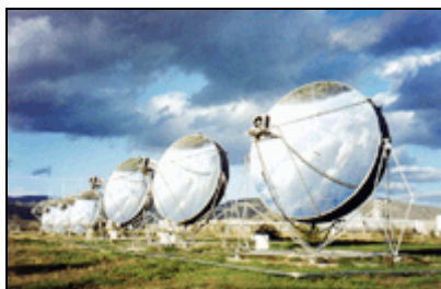
Σχήμα 3.16 Οι 6 μονάδες από 9 έως 10 KW λειτουργούν επιτυχώς στην Plataforma Solar de Almeria στην Ισπανία.
