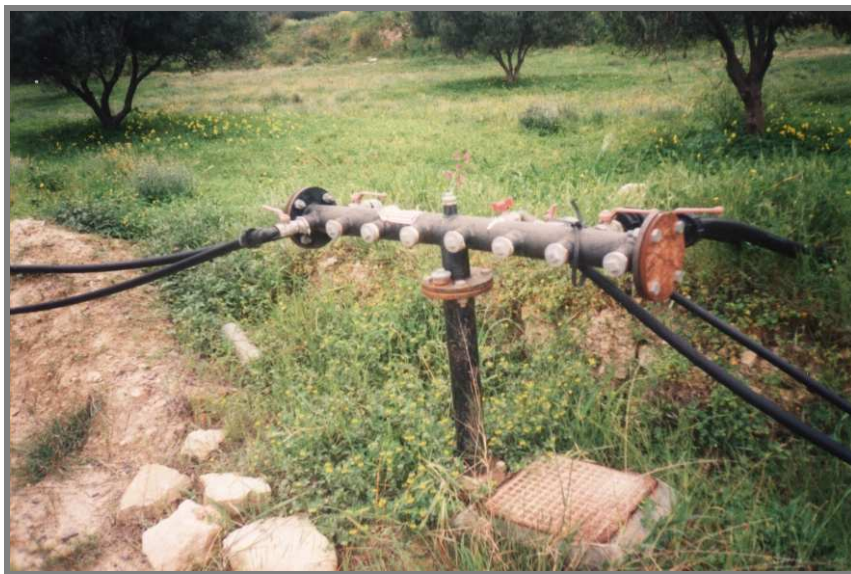
Σχήμα 4.25: Υδροστόμιο άρδευσης
