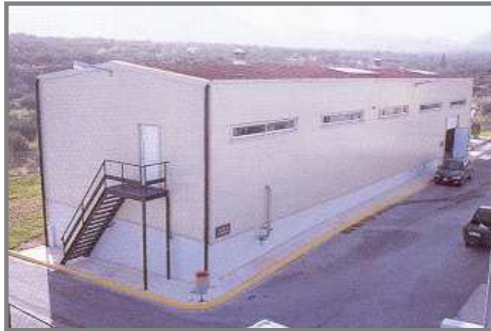
Σχήμα 4.6: Κτίριο εσχαρών, αμμοσυλλεκτών και λιποσυλλεκτών Ε.Ε.Λ. Χερσονήσου
