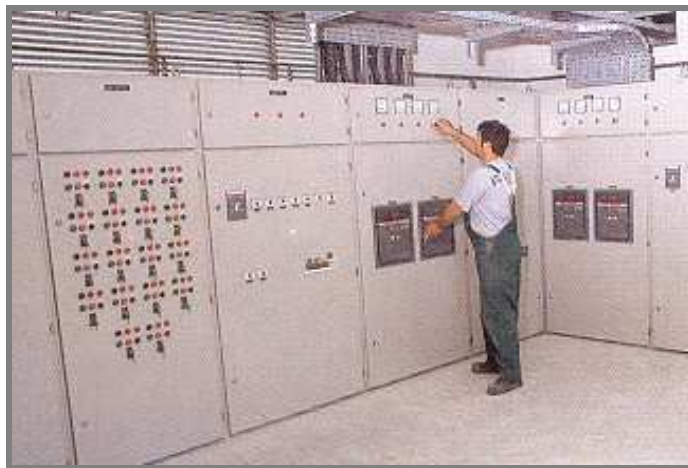
Σχήματα 4.21, 4.22: Κτίριο ενέργειας Ε.Ε.Λ. Χερσονήσου
