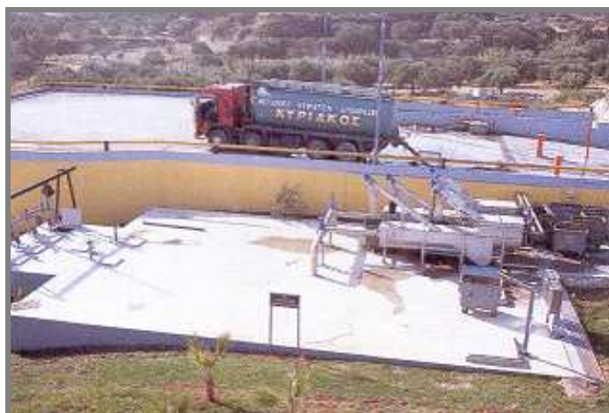
Σχήμα 4.17: Σταθμός υποδοχής βοθρολυμάτων Ε.Ε.Λ. Χερσονήσου
