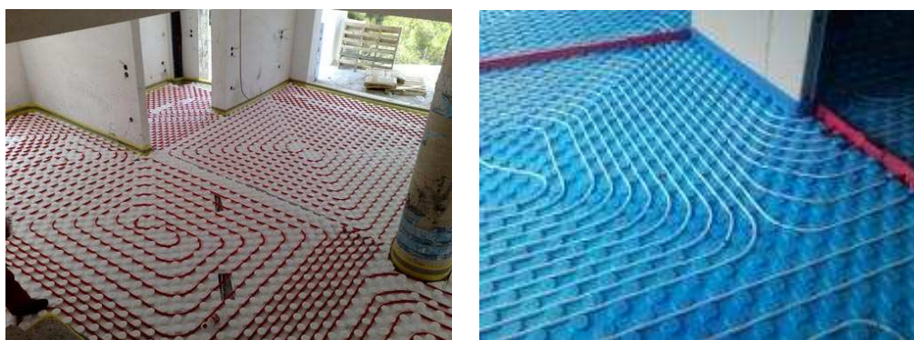
Σχήμα 6.11: ενδοδαπέδια θέρμανση
