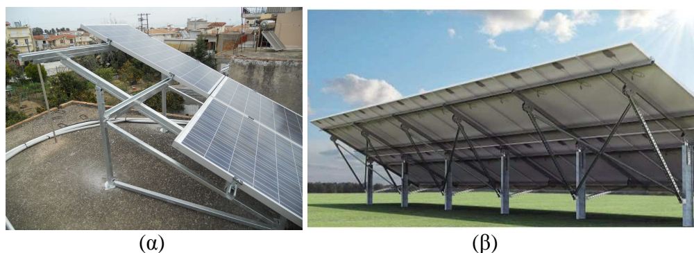
Σχήμα 4.1: βάση στήριξης (α), βάση στήριξης με δυνατότητα ρύθμισης κλίσης. (β)
