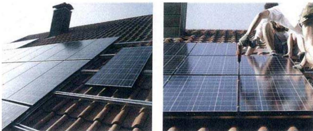
Σχήμα 4.6: Τοποθέτηση πάνελ
