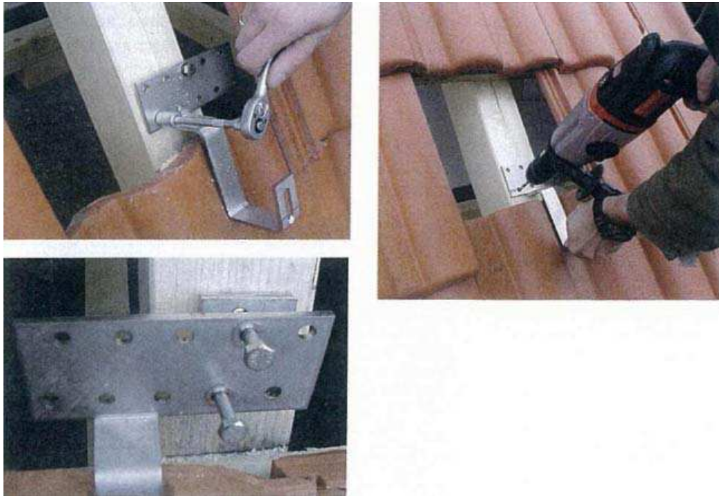
Σχήμα 4.3: Τοποθέτηση γάντζων στη στέγη για την ενσωμάτωση των πάνελ
