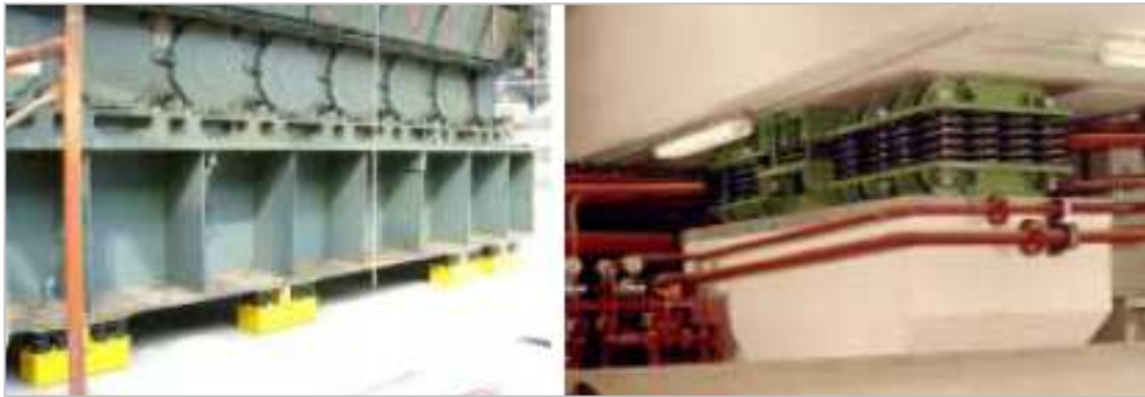
Εικόνα 5: Αντισεισμικά μέτρα προστασίας μηχανημάτων
