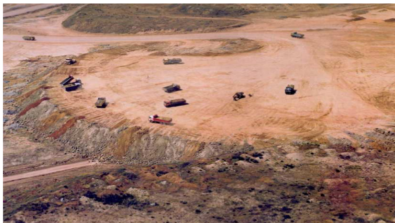
Εικόνα 15 Διάστρωση απόθεσης με χωματοουργικά οχήματα
