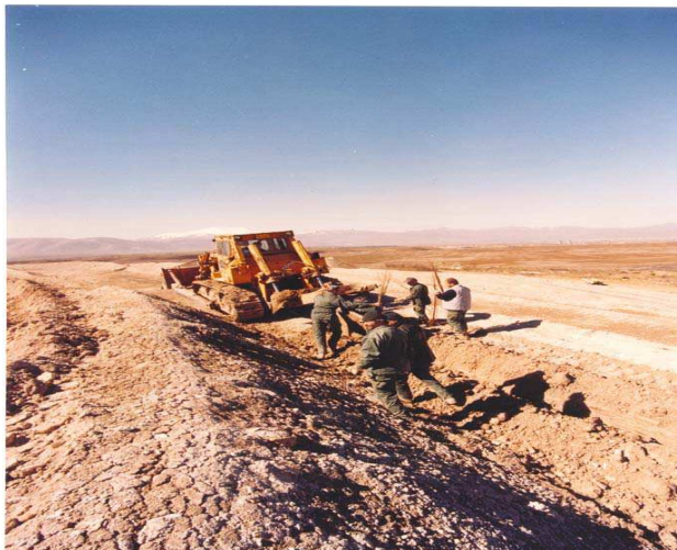
Εικόνα 16 Μέθοδος ripper
