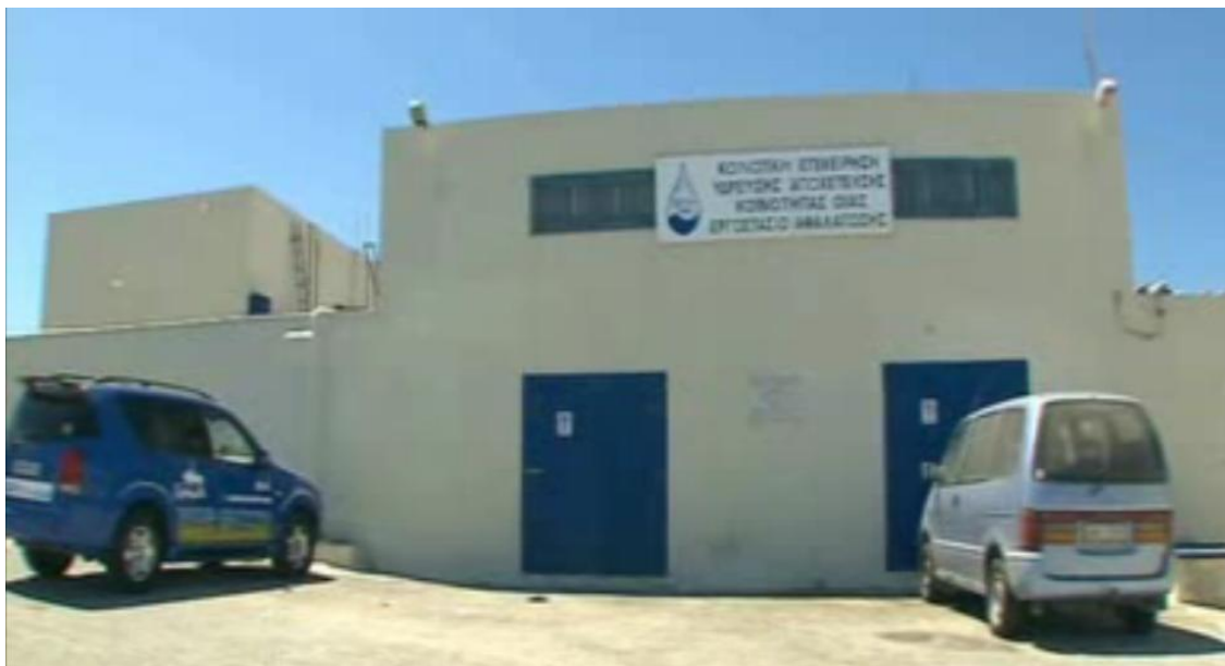
Εικόνα 7.1: Το κτίριο της μονάδας αφαλάτωσης της Οίας [36]
