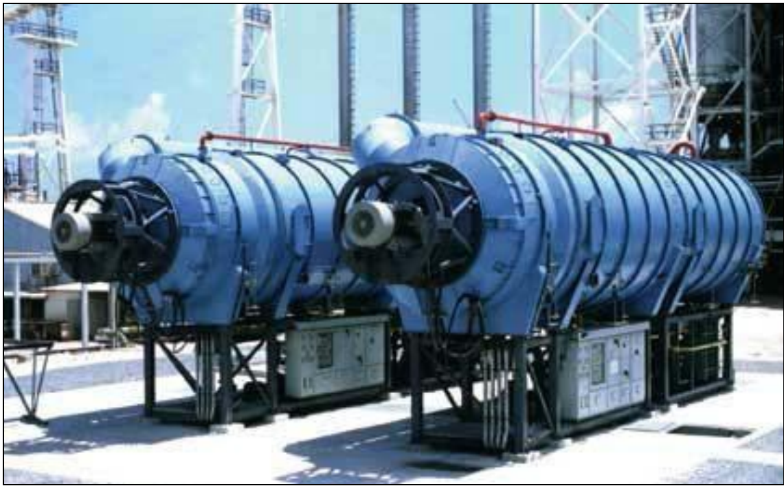
Εικόνα 5.3: Εγκατάσταση εξάτμισης με συμπίεση ατμών (Vapor Compression, VC) [27]
