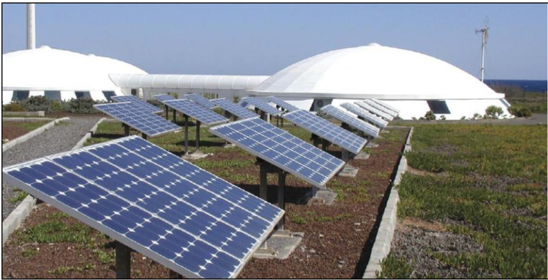
Εικόνα 5.5: Αυτόνομη Μονάδα Αφαλάτωσης Αντίστροφης Ώσμωσης στα Κανάρια Νησιά με φωτοβολταϊκά κελιά [27]
