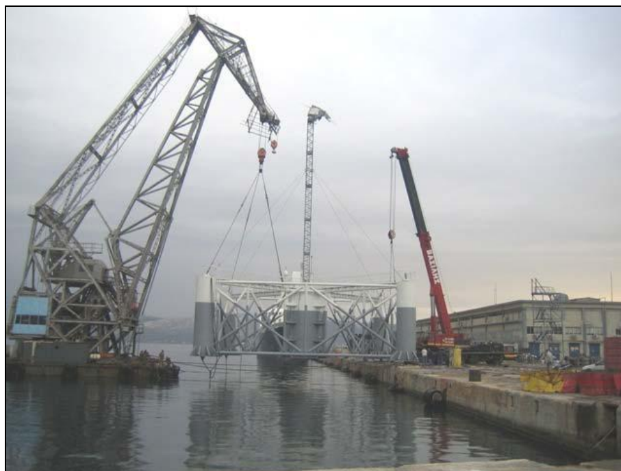
Εικόνα 6.3 Ναυπήγηση Υδριάδας [29]
