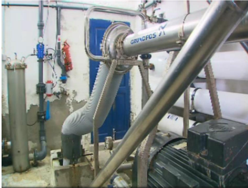
Εικόνα 7.9: Σύστημα απόρριψης της άλμης [36]
