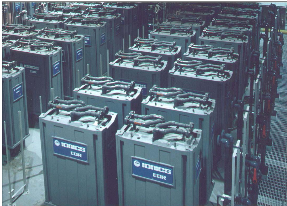
Εικόνα 5.4: Εγκατάσταση ηλεκτροδιάλυσης (Electro dialysis reversal, EDR) [29]
