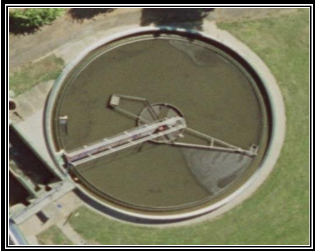
Εικόνα 2.2 Αεροφωτογραφία κυκλικής δεξαμενής καθίζησης.
