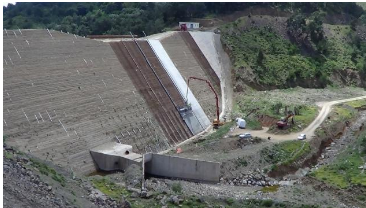
Εικόνα 6.5 : Το φράγμα Κόρης Γεφύρι (πηγή
