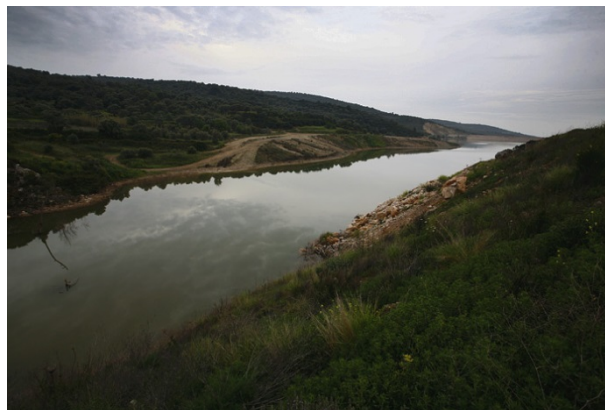
Εικόνα 6.1 : Το φράγμα του Κατράρη (πηγή
