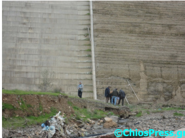
Εικόνα 6.4: Το φράγμα Κόρης Γεφύρι (πηγή
