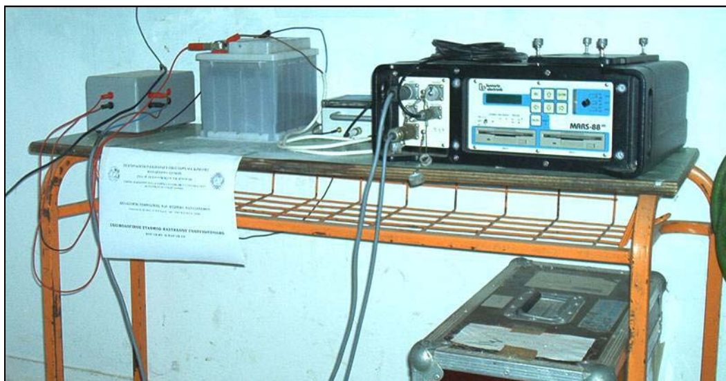
Φώτο 5: Αυτόνομος σεισμικός σταθμός στον Κάστελλο
