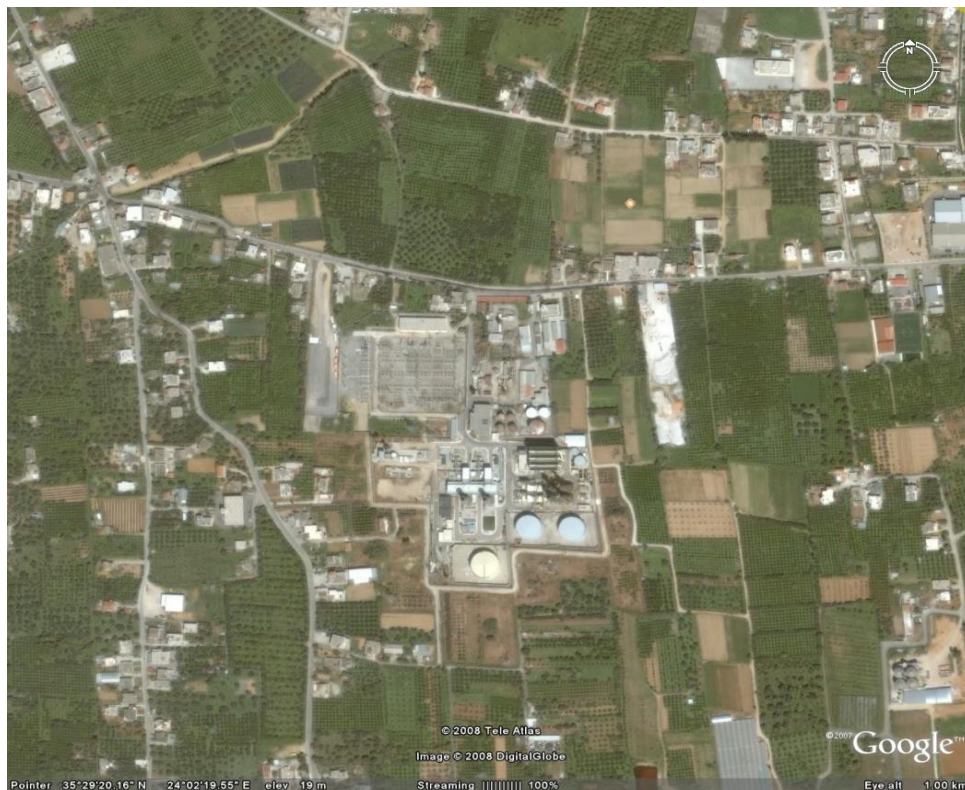
Σχήμα 1.2 Εικόνα του υποσταθμού ΔΕΗ Χανίων ( http://earth.google.com/ )
