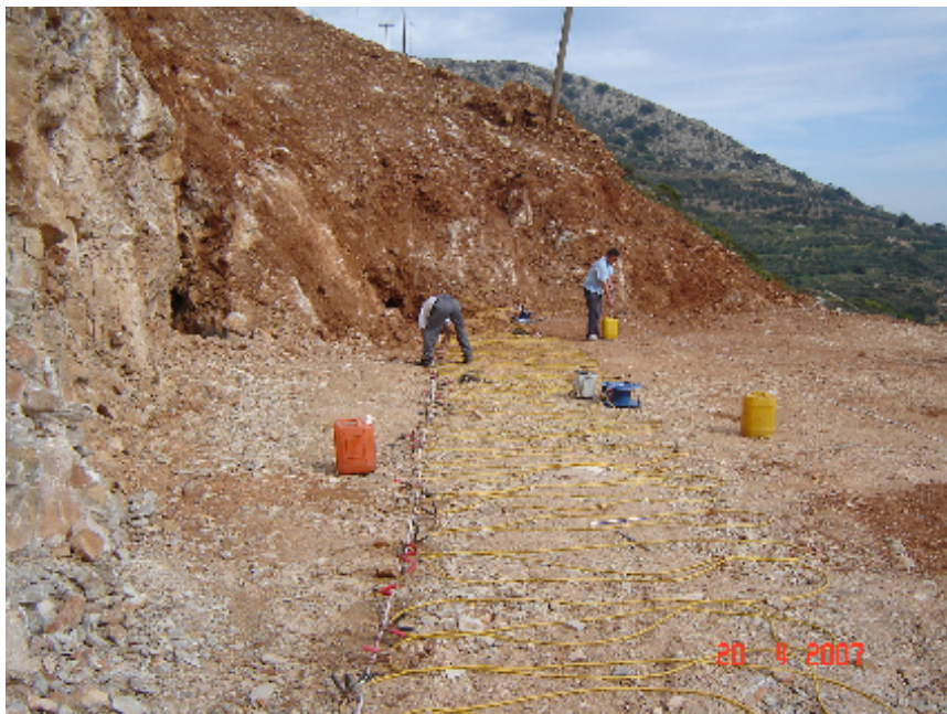
Φωτογραφία 9. Στη φωτογραφία απεικονίζεται το τέλος της πρώτης διασκόπησης καθώς και οι 2 πρώτες εμφανίσεις εγκοίλων εντός του χώρου διαμόρφωσης για τη θεμελίωση.
