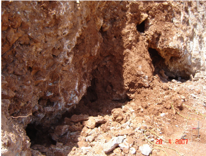
Φωτογραφία 16. Στη φωτογραφία απεικονίζονται τα έγκοιλα που εντοπίστηκαν στο πρανές του κάτω παταριού.
