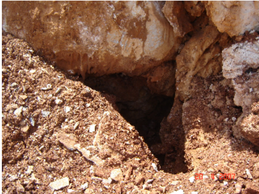
Φωτογραφία 4. Είσοδος καρστικού εγκοίλου σε περιοχή ανάντι του πρώτου (πάνω παταριού) χώρου θεμελίωσης.
