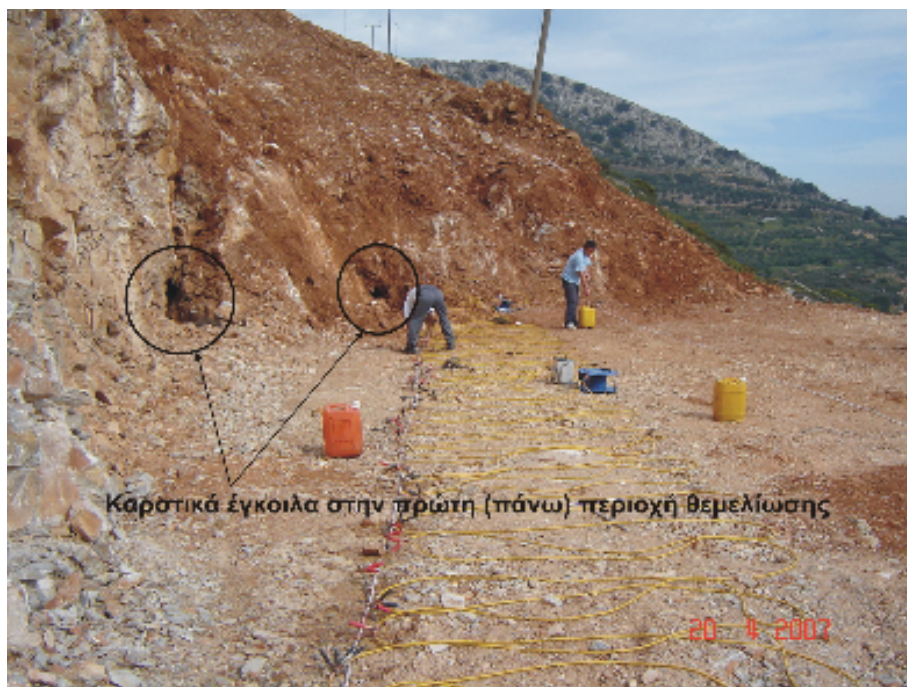
Φωτογραφία 1. Παρουσία καρστικών εγκοίλων μεσαίου μεγέθους όπως αποκαλύφθηκαν
