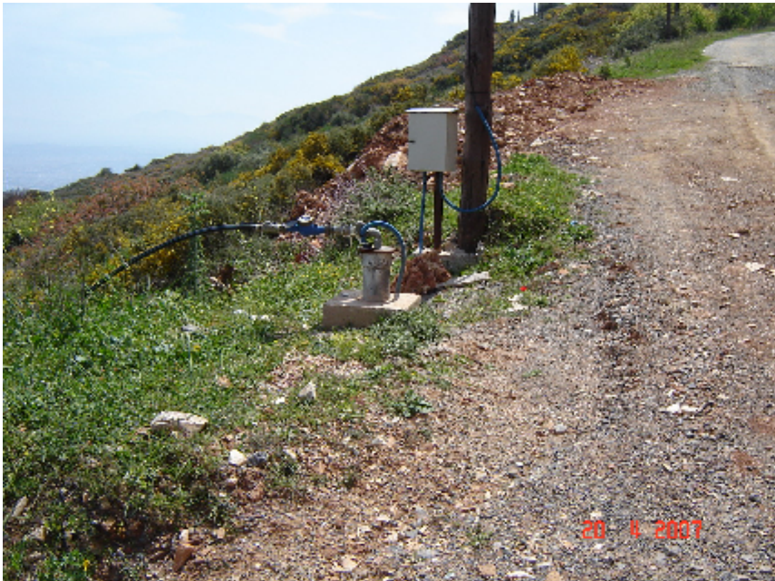
Φωτογραφία 6. Στη φωτογραφία εικονίζεται η κεφαλή της υδρογεώτρησης στην οποία παρουσιάστηκαν οι απώλειες ύδατος κατά τη διάτρηση από τα 40-70 μέτρα.
