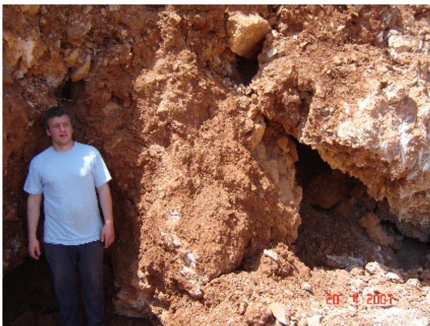
Φωτογραφία 18. Στη φωτογραφία απεικονίζονται τα έγκοιλα που εντοπίστηκαν στο πρανές του κάτω παταριού.
