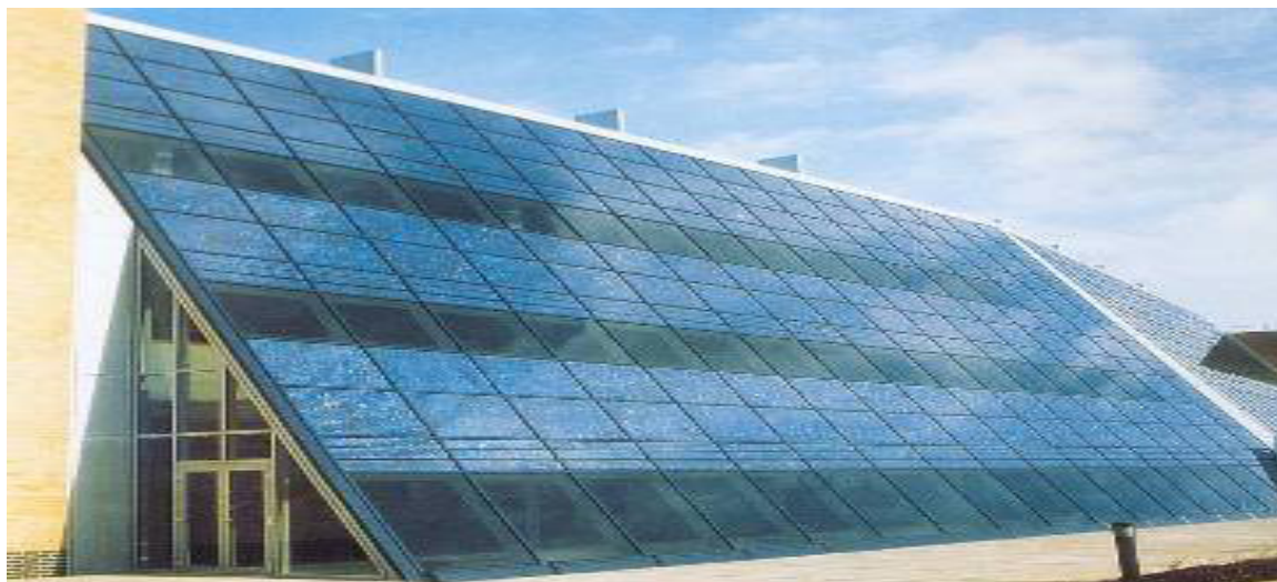
Σχήμα 21 : Φ/Β σε πρόσοψη κτιρίου
