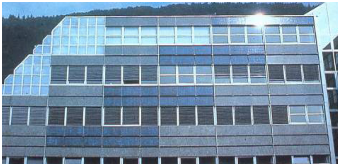
Σχήμα 16 :Φωτοβολταϊκά σε πρόσοψη κτιρίου
