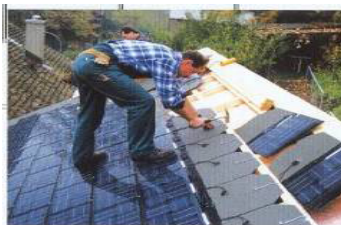
Σχήμα 18 : Πέρασμα Φ/Β πάνω σε σκεπή
