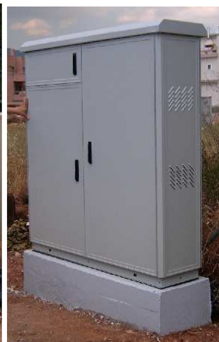
Σχήμα 47 Επέκταση Χώρου με αντικατάσταση περιβλήματος υφιστάμενου KV σε έργα FTTC 235 .
