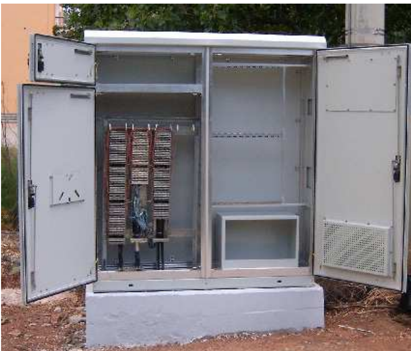
Σχήμα 47 Επέκταση Χώρου με αντικατάσταση περιβλήματος υφιστάμενου KV σε έργα FTTC 235 .
