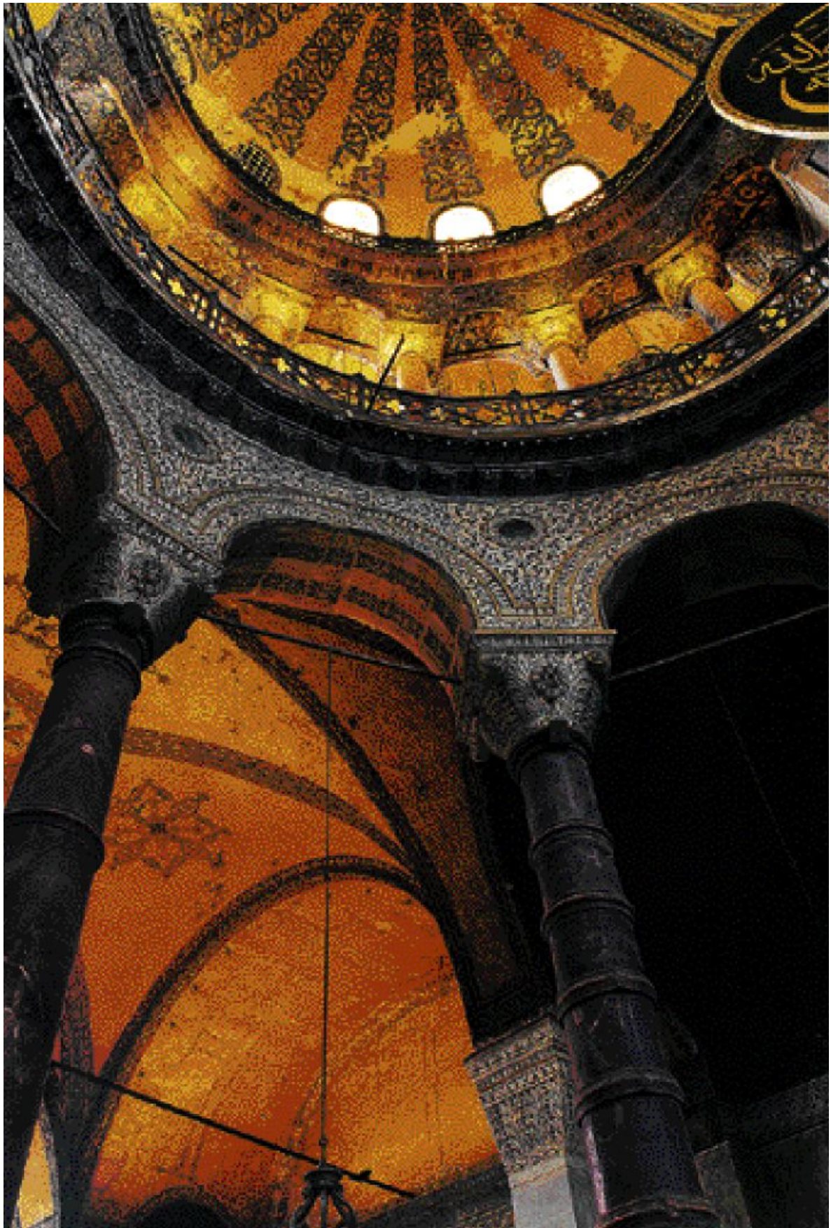
Εικ. 17. Η στήριξη του τρούλου της Αγίας Σοφίας
