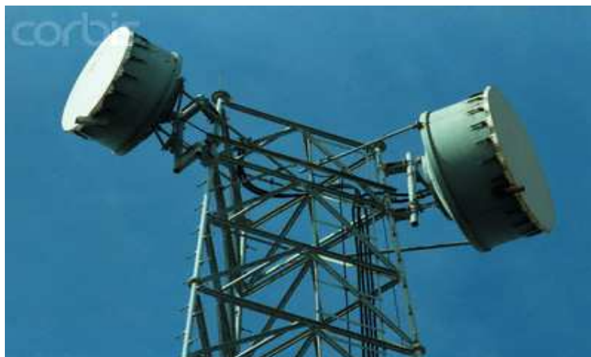
Σχήμα 3.3 : Μικροκυματικές κεραίες σταθμών βάσης κινητής τηλεφωνίας
