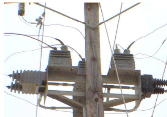
Σχήμα 2.19: Θερμόγραμμα και φωτογραφία Μ/Σ ρεύματος.
