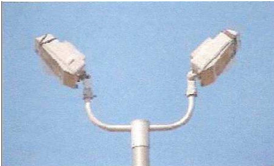
Εικόνα 7-3: Φωτιστικό σώμα κατακόρυφης διάταξης
