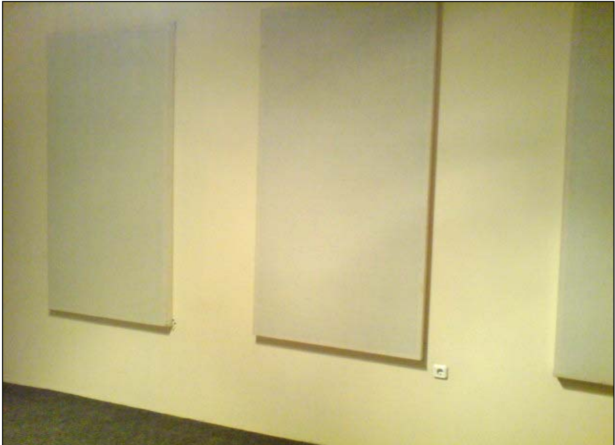
Φωτ. 1.33 : Panels στερεωμένα σε τοίχο
