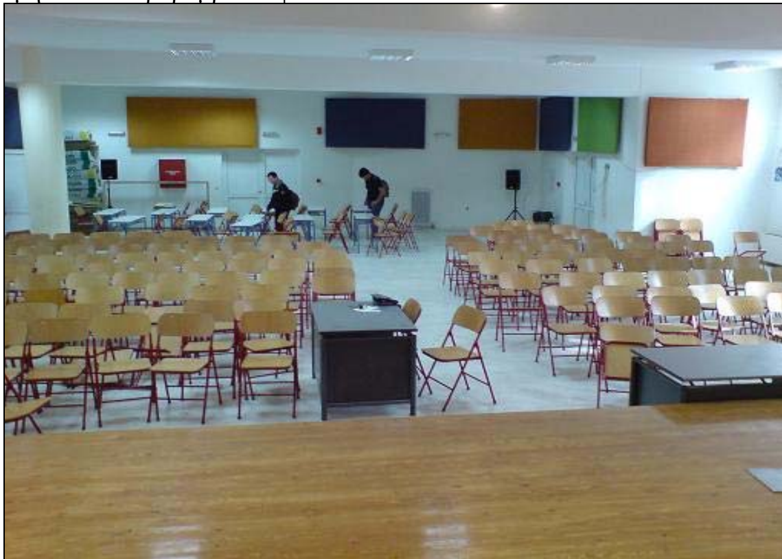
Φωτ. 1.32 : Τα υπάρχον τοποθετημένα ηχοαπορροφητικά panel και αριστερά στο βάθος ο πετροβάμβακας
