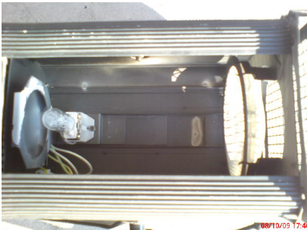
Φωτ. 3.10: Ανοιχτό θεατρικό φωτιστικό σώμα τύπου PC(λυχνία ,κοίλο ανακλαστήρα , συγκεντρωτικό φακό )
