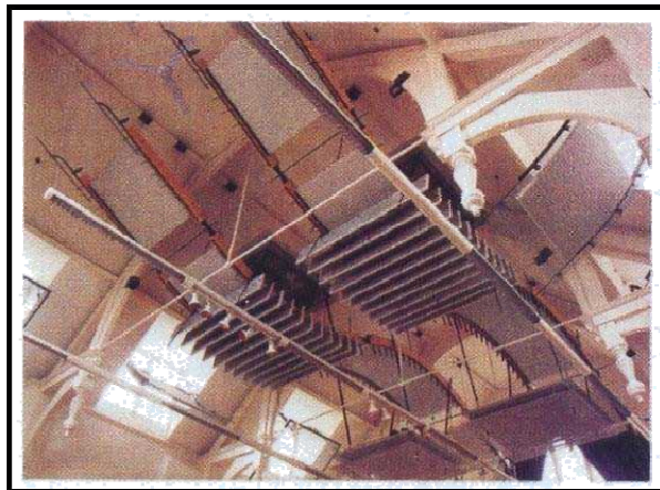
Σχήμα 1.24: Σύνθεση αναρτημένων στοιχείων ηχοαπορρόφησης, ηχοδιάχυσης και φωτισμού . (Τσινίκας 2005 σελ.61)
