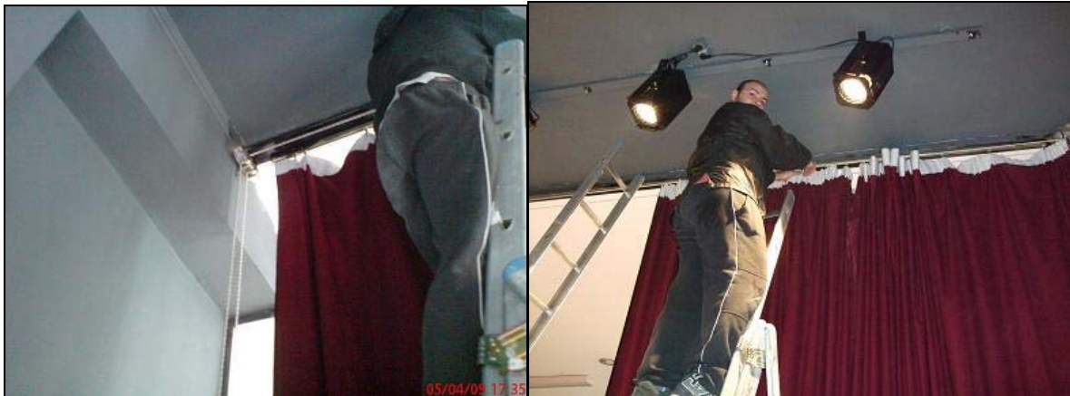
Φωτ. 1.38-39 : Τοποθέτηση της βελούδινης αυλαίας πάνω στο σιδηρόδρομο
