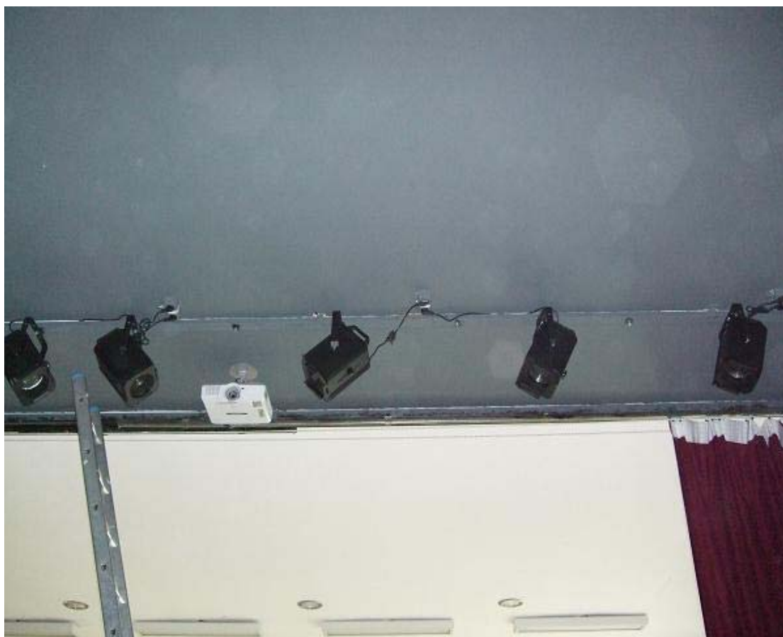
Φωτ 3.20: Η κατασκευή εσωτερικά
