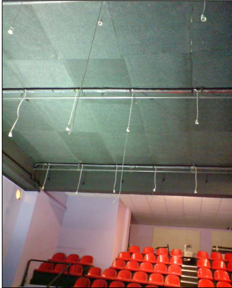
Φωτ. 1.37 :Τοποθέτηση ηχοαπορροφητικού πολυουρεθάνης στην οροφή
