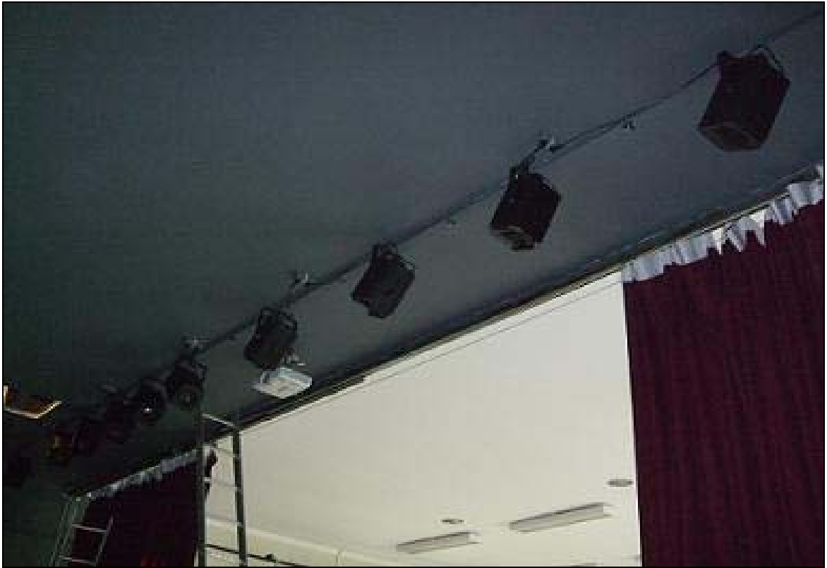
Φωτ. 1.42 :Άποψη από την τοποθέτηση αυλαίας στο πολύκεντρο Νέας Κούταλης στην Λήμνο.
