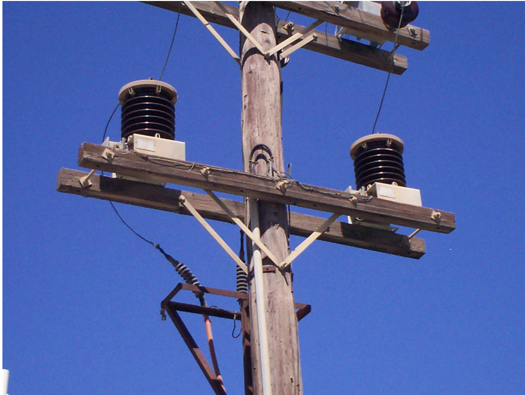
Μ/Σ εντάσεως με κλίμακα N/5A (ανάλογα με την κατανάλωση)
