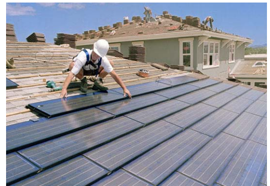
Εικόνα 16: Τοποθέτηση Φ/Β Σε Οροφή <tglarch.worldpress.com>
