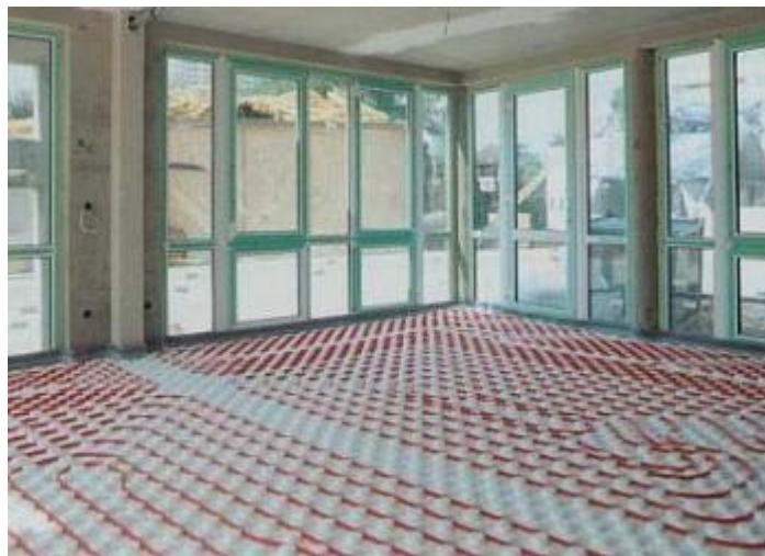
Εικόνα 46: Εφαρμογή ενδοδαπέδιας θέρμανσης <Μοναχός Ηλεκτρομηχανολογικά Α.Ε>
