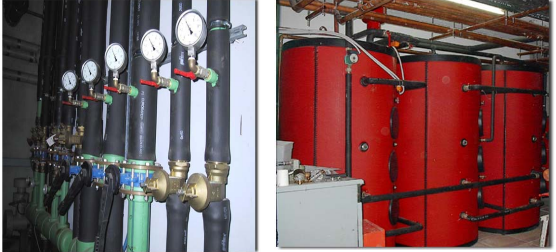
Εικόνα 44: Θερμομόνωση επιφανειών<res.gr>
