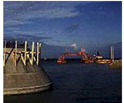
Εικόνα 18: Κατασκευή αιολικού πάρκου με οπλισμένο σκυρόδεμα <spitia.gr>
