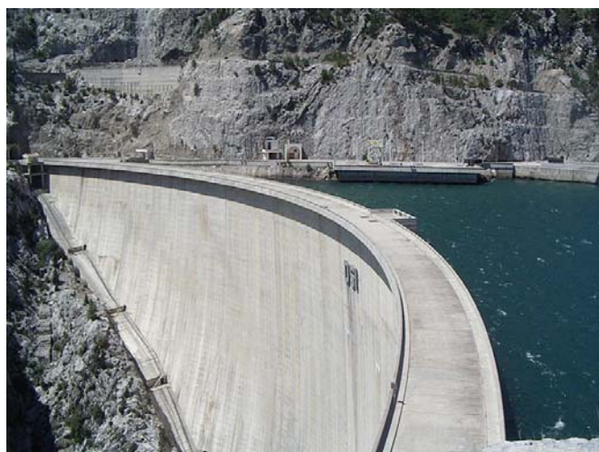
Εικόνα 37: Υδροηλεκτρικό Φράγμα <easypedia.gr>
