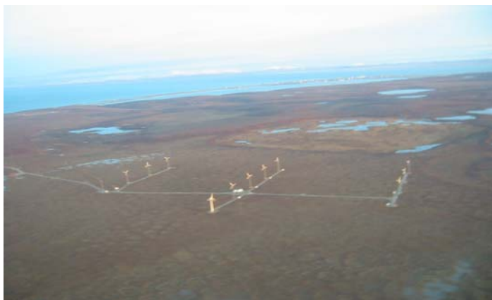
Εικ. 7-2 Αιολικό πάρκο στο Kotzebue της Αλάσκας
