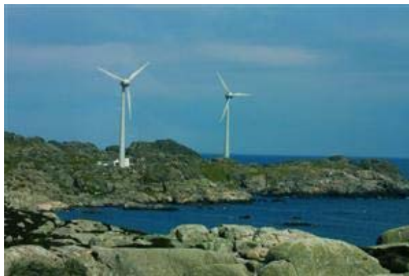
Εικ. 8-19 Ανεμογεννήτριες στο νησί Utsira
