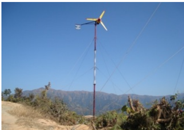
Εικ. 7-5 400 Watt μικρή ανεμογεννήτρια στο χωρίο Pyuthan
