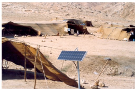
Εικ. 4-10 Φωτοβολταϊκά συστήματα για την ηλεκτροδότηση οικισμού Βεδουίνων
