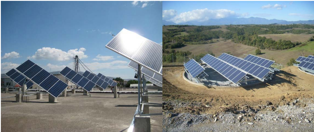
Εικ. 3-18 (Α) Εικόνα 3-33 (Β): Μονοαξονικά σύστημα παρακολούθησης (Α) οριζόντιου άξονα, (Β) κάθετου άξονα
