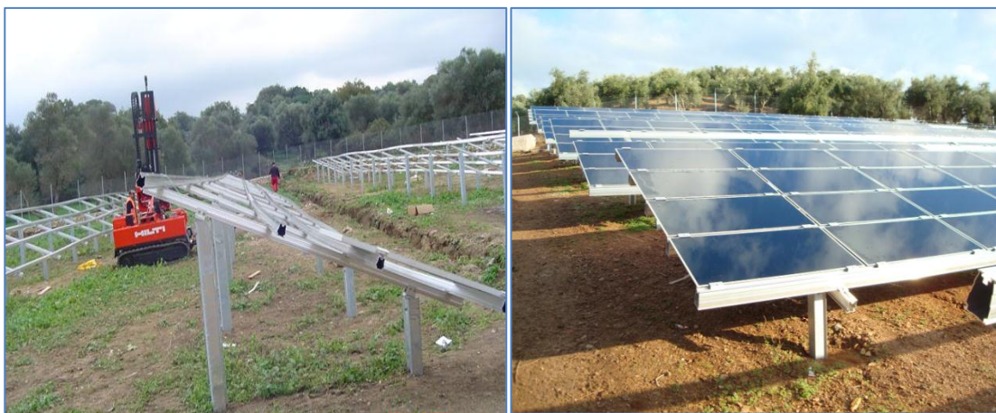
Εικόνα 5. Σύστημα στήριξης αλουμινίου HILTI MSP – AL
