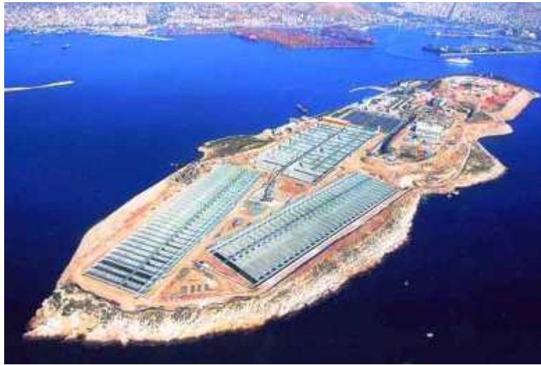
ΕΙΚΟΝΑ 38 ΠΛΗΘΟΣ ΑΝΤΛΙΩΝ ΚΑΙ ΚΙΝΗΤΗΡΙΩΝ ΜΗΧΑΝΩΝ ΣΤΙΣ ΕΓΚΑΤΑΣΤΑΣΕΙΣ ΤΗΣ ΕΥΔΑΠ, ΣΤΗΝ ΦΩΤΟΓΡΑΦΙΑ ΟΙ ΕΓΚΑΤΑΣΤΑΣΕΙΣ ΤΗΣ ΨΥΤΤΑΛΕΙΑΣ [19]
