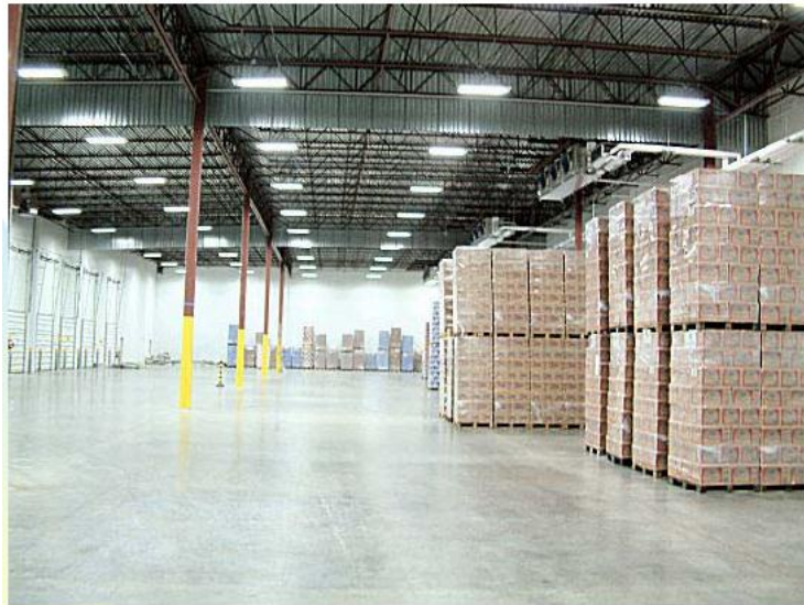
ΕΙΚΟΝΑ 32 ΦΩΤΙΣΜΟΣ ΣΕ ΨΥΚΤΙΚΟ ΘΑΛΑΜΟ
