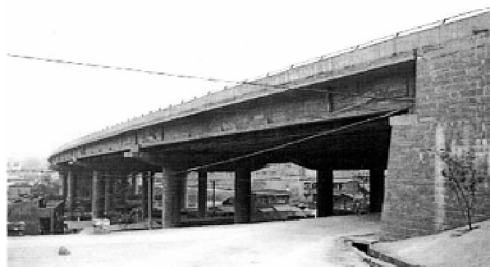
Σχήμα 4.14: Φωτογραφία από την κατασκευή με αισθητήρες οπτικών ινών της γέφυρας Hongcaofang στο Chongqing της Κίνας
