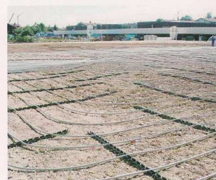
Τοποθέτηση οριζόντιων γεωθερμικών εναλλάκτων RAUGEO
