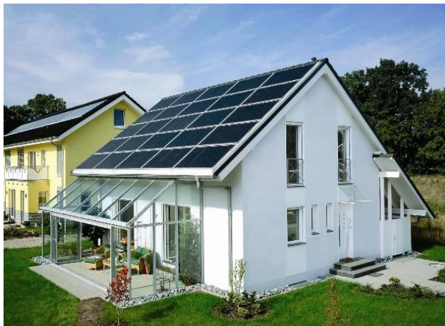
Εικόνα 3-38: Εγκατάσταση Φ/Β σε κεκλιμένη στέγη
