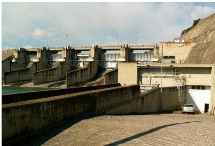
Εικόνα 2-8: Μ.ΥΗ.Σ. Στρατός II Αγρινίου, εγκατεστημένης ισχύος 6,3 MW, στο Νομό Αιτωλοακαρνανίας
