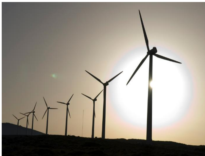
Εικόνα 2-5: Αιολικό Πάρκο εγκατεστημένης ισχύος 13,20 MW στη Ξηρολίμνη Σητείας, Κρήτη
