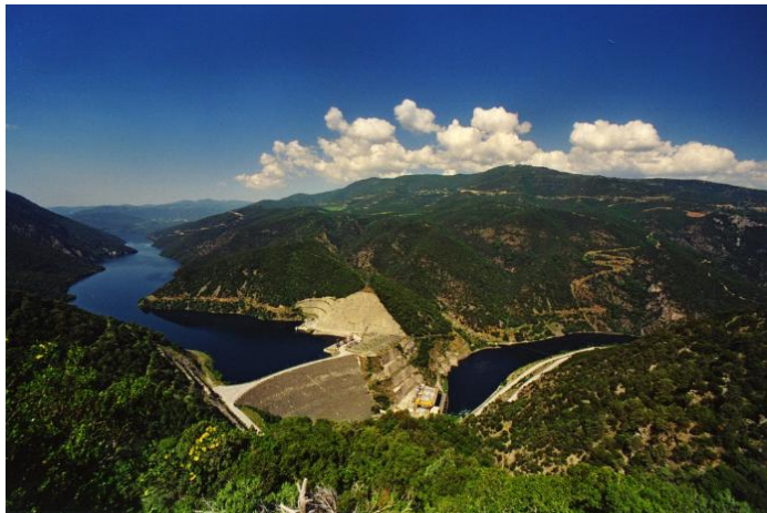
Εικόνα 2-7: ΥΗ.Σ. Σφηκιάς εγκατεστημένης ισχύος 315 MW, στο ποταμό του Αλιάκμονα
