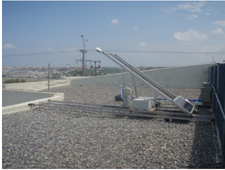
Θέση Συστοιχίας 1, Θέση Πλαισίου 1 (Αρχικές Θέσεις)
