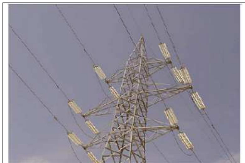
Σχήμα 1.9 Γυάλινοι μονωτήρες σε πυλώνες διέλευσης
