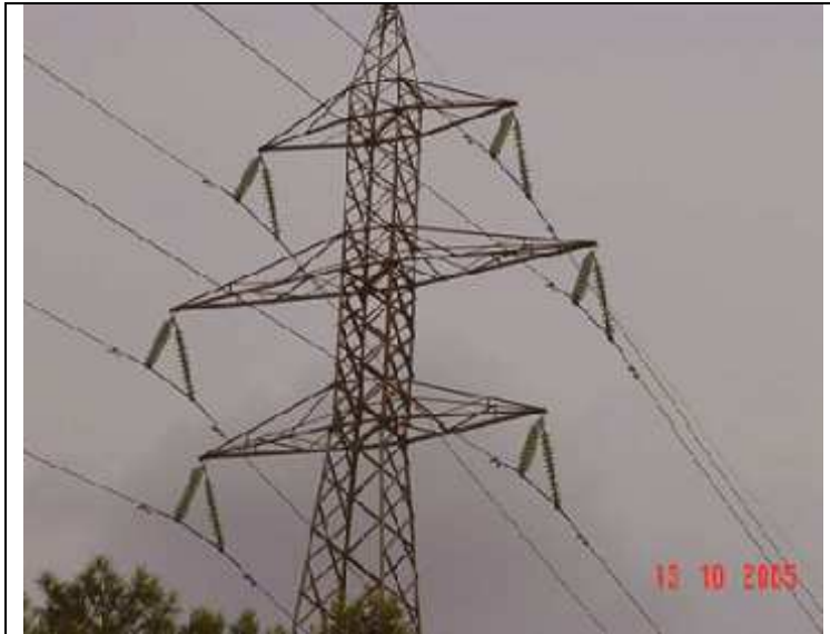
Σχήμα 1.10 Γυάλινοι μονωτήρες σε διάταξη λάμδα.
