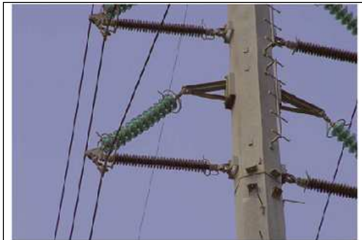
Σχήμα 1.11 Γυάλινοι μονωτήρες σε διάταξη ιστού.
