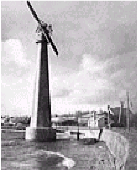
Σχήμα 13 Δανέζικη μηχανή με δυο πτερύγια (Πηγή: windpower.dk)
