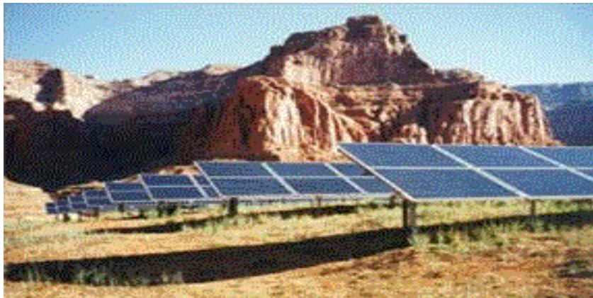
Σχήμα 8: Φ/Β γεννήτρια. Χαρακτηριστικά Φ/Β πάνελ: V_m = 69.2V , I_m = 2.31A εάν τα 4 πλαίσια συνδεθούν σε σειρά, V_m = 17.3V , I_m = 9.24A εάν τα 4 πλαίσια συνδεθούν παράλληλα
