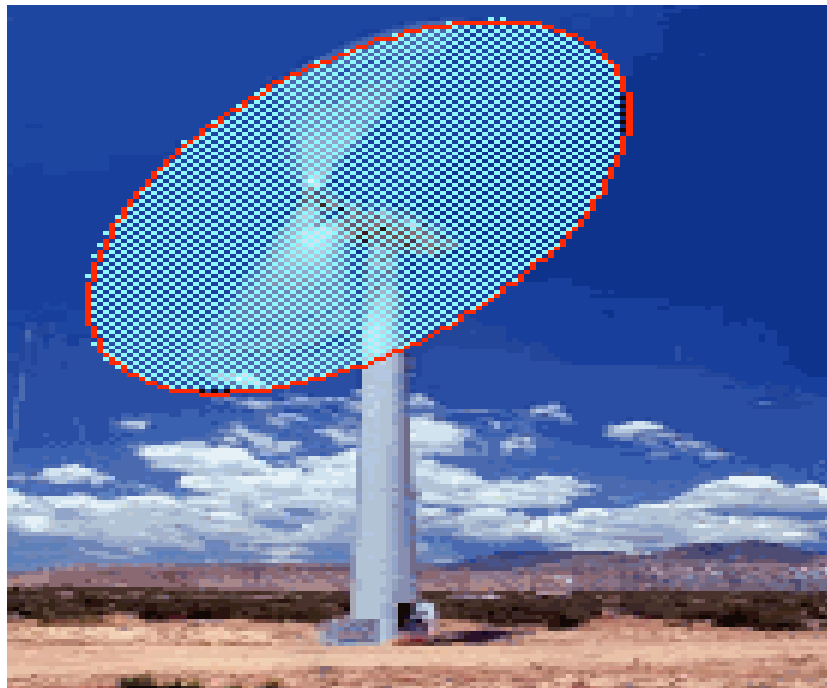
Σχήμα 20 Επιφάνεια σάρωσης του δρομέα μιας ανεμογεννήτριας.
