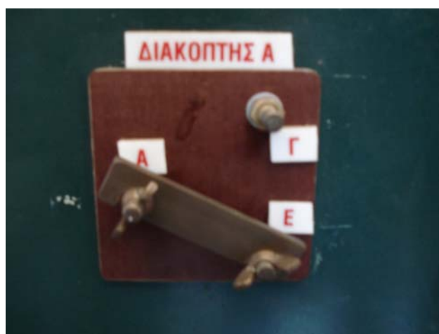
Εικόνα 13 : Διακόπτης Α συνδεδεμένος με το Ε
