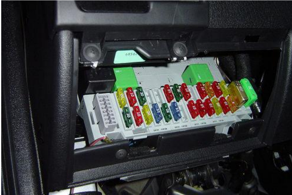
Εικόνα 32: Συσκευές προστασίας κυκλωμάτων (Ασφαλειοθήκες)
