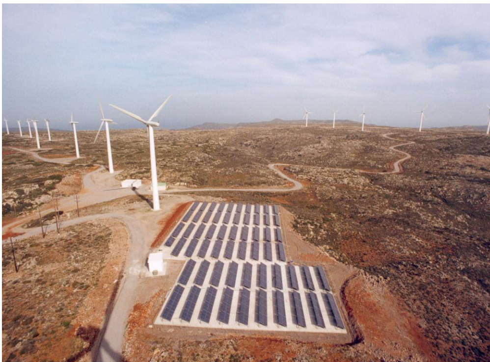
Σχ.6.1 Το φωτοβολταϊκό πάρκο της εταιρίας Χ. ΡΟΚΑΣ ΑΒΕΕ .
