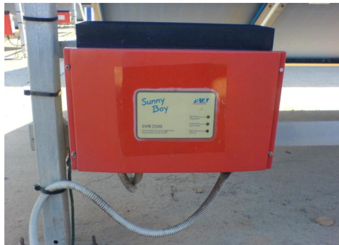
Σχ.6.10 Ο αντιστροφέας ( inverter ) Sunny Boy SWR 2500 όπου αποτελείται η κάθε συστοιχία.
