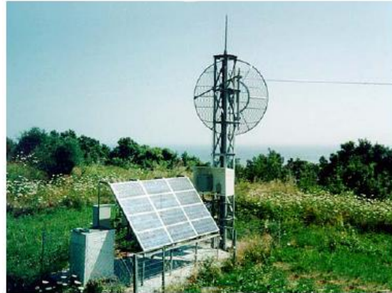
Σχ.1.4 Πάνω από 1000 φάρους στην χώρα μας ισχύος πάνω από 70 kWp τροφοδοτούνται με φωτοβολταϊκά συστήματα, καθώς και πλήθος από αυτόνομα τηλεπικοινωνιακά συστήματα σε αναμεταδότες σταθερής και κινητής τηλεφωνίας.
