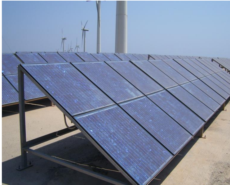
Σχ.6.9 Οι συστοιχίες στήριξης των φωτοβολταϊκών πλαισίων του πάρκου, κατασκευάστηκαν από την εταιρία ΡΟΚΑΣ στο εργοστάσιο της στην Τρίπολη.
