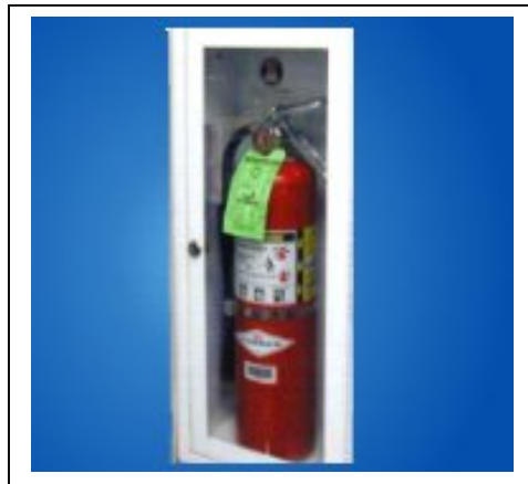
Σχήμα 7.1 Σταθμός πυρασφάλειας.
