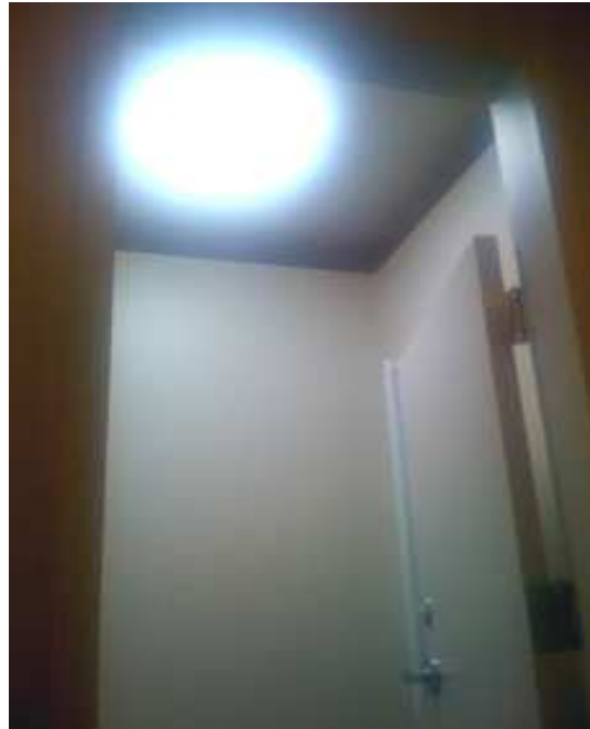
Έξοδος φωτός solartube
