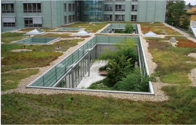
Φωτογραφία 1.4 Φυτεμένο δώμα. (Building Green Team, 2012)
