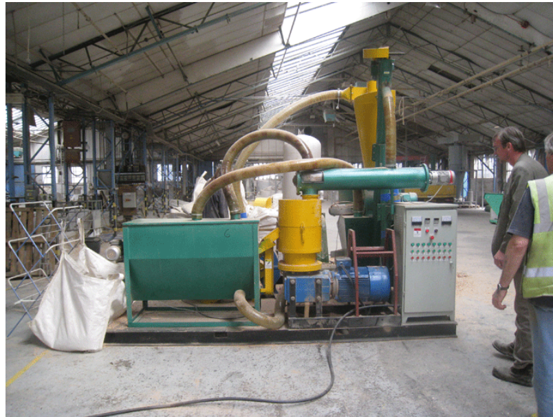
Εικόνα 4.12: Φωτογραφίες μεταλλικών κτιρίων.
