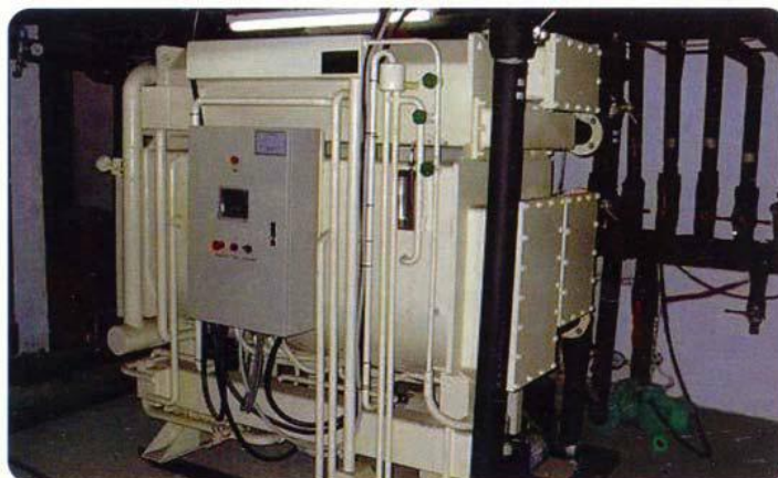
Εικόνα 4.1: Ψύκτης απορρόφησης 105kW
