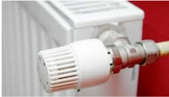
Εικόνα 2.5: Θερμοστατικές βαλβίδες
