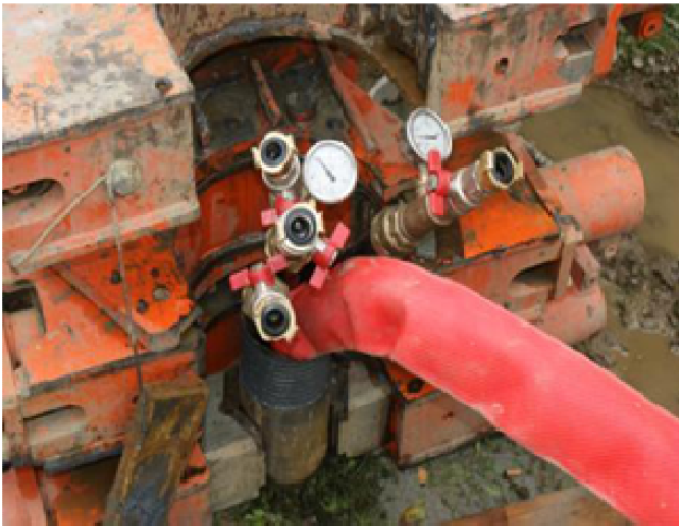
Εικόνα 12.5 – Κόψτε τους σωλήνες στο απαιτούμενο μήκος, γεμίστε τα με νερό, εφαρμόστε μια πρώτη πίεση και σφραγίστε τους (εικόνα: Polydynamics Engineering Zurich)
