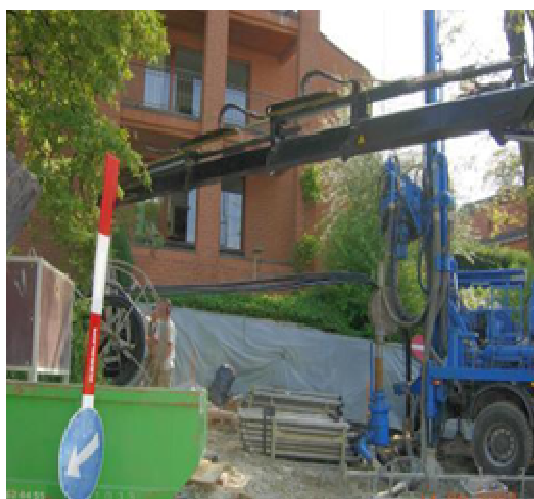
Εικόνα 12.4 – Οδηγοί κύλινδροι για να εξασφαλίσει κάθετη εισαγωγή (εικόνα: Polydynamics Engineering Zurich)
