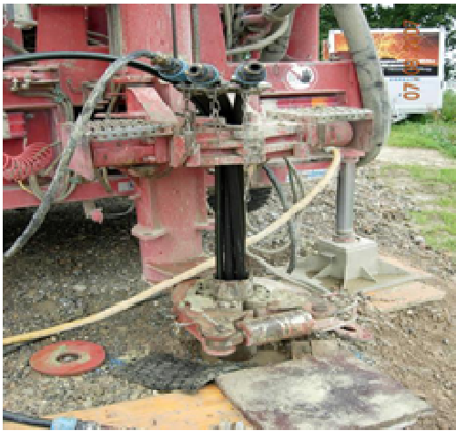
Εικόνα 12.7 – Κατά την έγχυση ενέματος, το βοηθητικό περίβλημα εξακολουθεί να προστατεύει τη γεώτρηση από το να καταρρεύσει. Ο ΒΗΕ είναι υπό πίεση (εικόνα: Polydynamics Μηχανικών Ζυρίχη)
