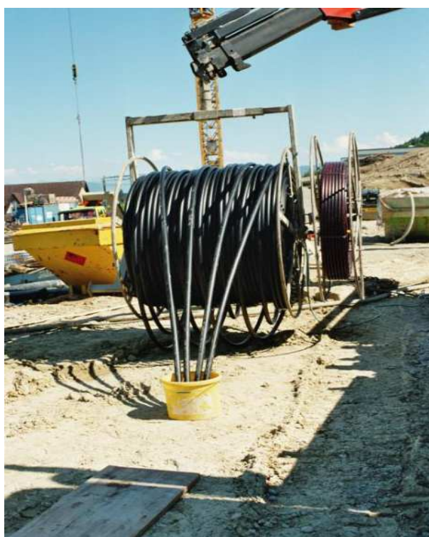
Εικόνα 12.1. BHE σε έναν ανελλικτή κατά την πρώτη δοκιμή πυκνότητας με τη χρήση αέρα (εικόνα: Polydynamics Engineering Zurich)
