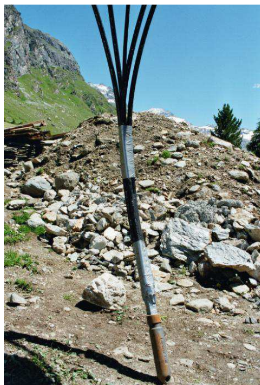
Εικόνα 12.2. BHE έτοιμος για τοποθέτηση με ένα πρόσθετο βάρος, με προστατευμένη βάση και έναν πέμπτο σωλήνα έγχυσης (εικόνα: Polydynamics Engineering Zurich)
