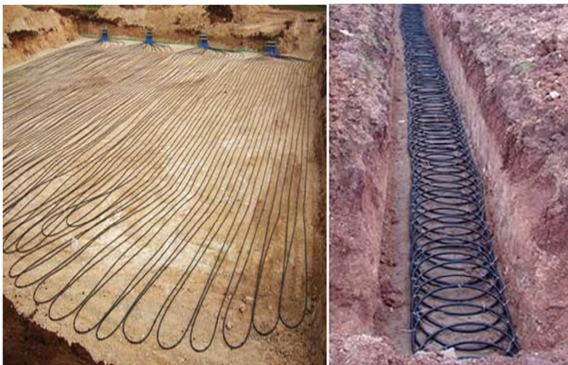
Εικόνες 17. Διατάξεις Σωληνώσεων πολυαιθυλενίου οριζόντιας γεωθερμίας.
