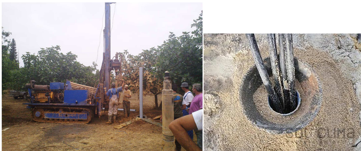
Εικόνες 19. Γεωτρήσεις αβαθούς γεωθερμίας.
