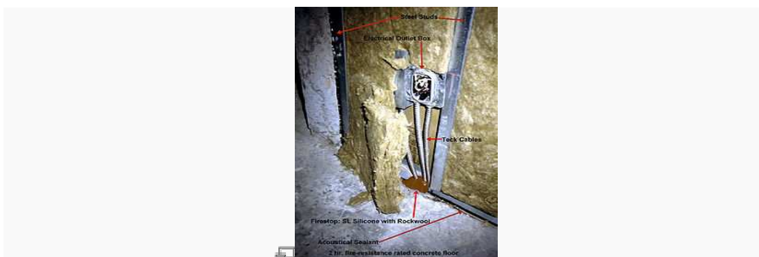
Εικόνα 7. Μόνωση με πετροβάμβακα σε κατασκευή με γυψοσανίδες.
