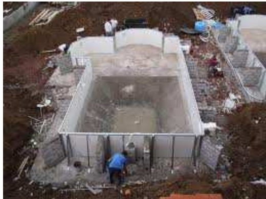
Εικόνα 66. Στα περιμετρικά τοιχώματα της πισίνας τοποθετούνται πάνελ πολυουρεθάνης διαστάσεων. Τα πάνελ πολυουρεθάνης αποτελούνται από δύο ειδικά διαμορφωμένα ελασματόφυλλα, ανάμεσα στα οποία εγχύεται και ωριμάζει μέσα σε θερμαινόμενη πρέσσα σκληρός αφρός πολυουρεθάνης.. Τα ελασματόφυλλα αποτελούνται από γαλβανισμένη εν θερμό λαμαρίνα με και είναι βαμμένα με ακρυλική βαφή.
