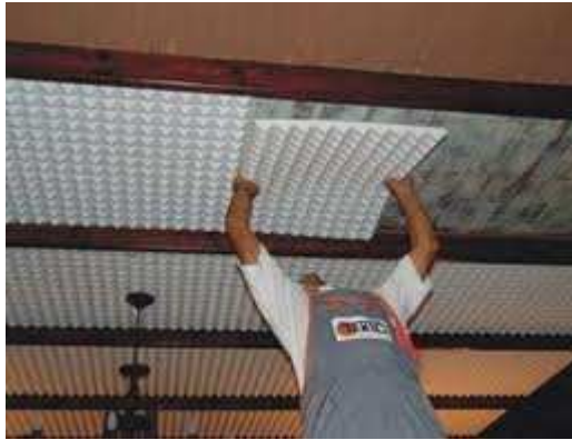
Εικόνα 31. Στο εσωτερικό των τοίχων και ορόφων μεταξύ των τούβλων τοποθετούνται μονωτικά υλικά (φενιζόλ, υαλοβάμβακας).
