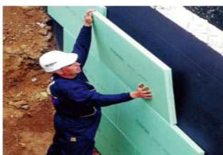
Εικόνα 39. Τοποθέτηση XPS.
