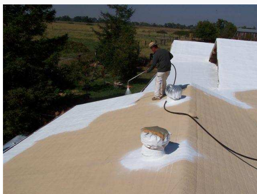
Εικόνα 14. Ο ψεκαζόμενος αφρός πολυουρεθάνης χρησιμοποιείται για μόνωση (θερμομόνωση).
