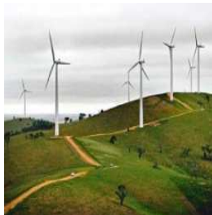
Εικόνα 5: Αιολικό πάρκο 20MW p στη Λάρακα
