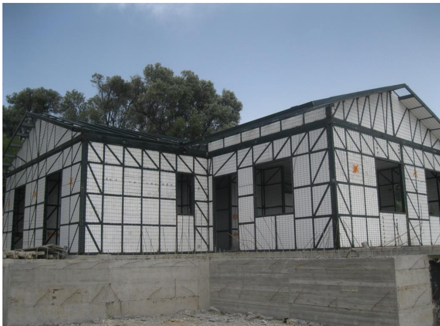
Εικόνα 4. Κατασκευή από μεταλλικό χωροδικτύωμα
