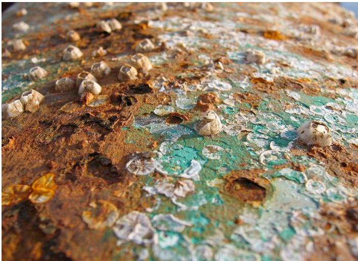
Εικόνα 1.2 : Διάβρωση στο μεταλλικό κύτος του πλοίου
