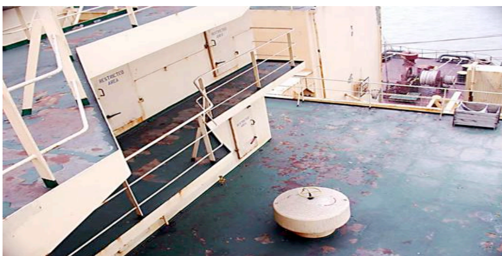
Εικόνα 4.6 : Διάβρωση στους χώρους του εξωτερικού καταστρώματος
